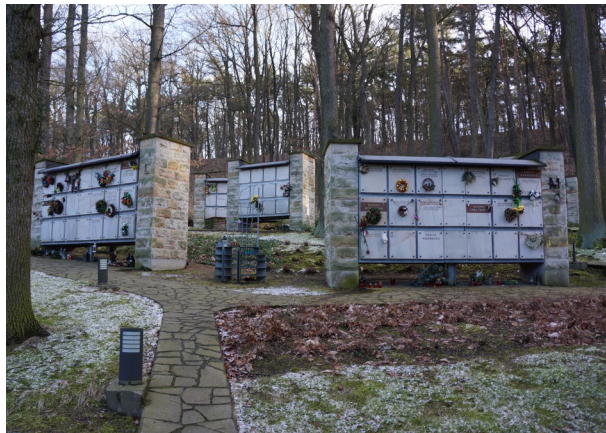
155 Samostatná kolumbária v rozvolněné struktuře – skupina sousedí s prostorem lesního hřbitova [ Praha 5, Motolský hřbitov ]
