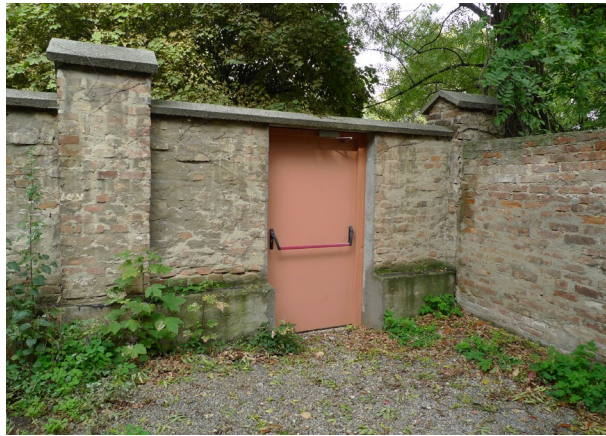
036 Boční branka, osazená z vnitřní strany panikovým kováním, umožňuje opuštění hřbitova po uzamčení hlavního vstupu [ Rakousko, Vídeň, St. Marx Friedhof ]
