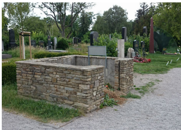
118 Biologický odpad je vhodné soustředit do stavebně řešených zákoutí; objekt má být přizpůsoben charakteru hřbitovního oddělení [ Rakousko, Vídeň, Zentralfriedhof ]
