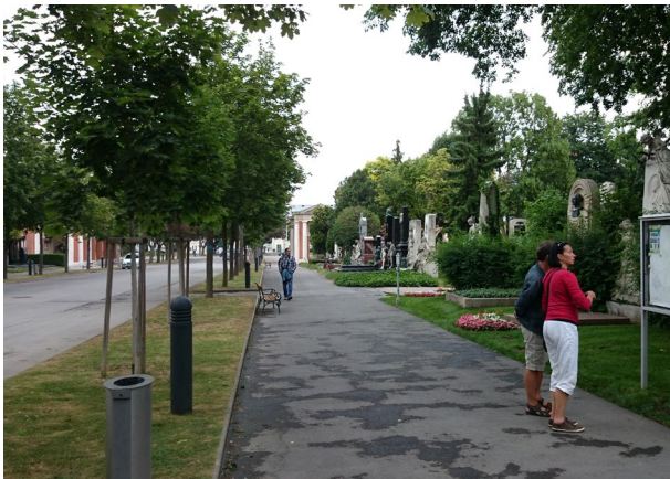
083 Nízké osvětlovací sloupky na hlavní cestě; světlo je směřováno k zemi a slouží jako poziční – bezpečnostní osvětlení [ Rakousko, Vídeň, Zentralfriedhof ]
