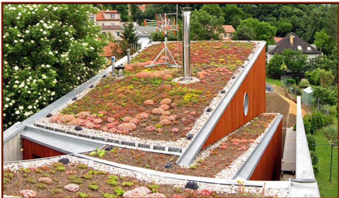
Obr. 30: Extenzivní zelená střecha, Dům v úžině, Praha-Jinonice. (Foto: Pavel Dostál, 2015.)
