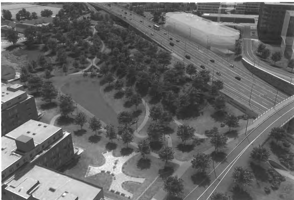
Retenční nádrž přírodního charakteru pro odvodnění radiály začleněná nového parku.
