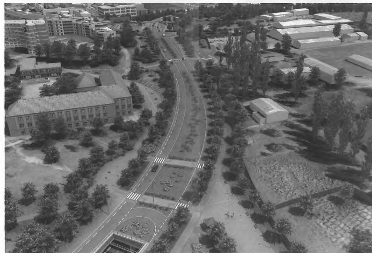
Radlická radiála v tunelovém provedení. Na stropě tunelu Nová Radlická ulice jako velkorysá městská třída s rezervou pro výhledovou tramvajovou trať podporující budoucí možnou zástavbu.
