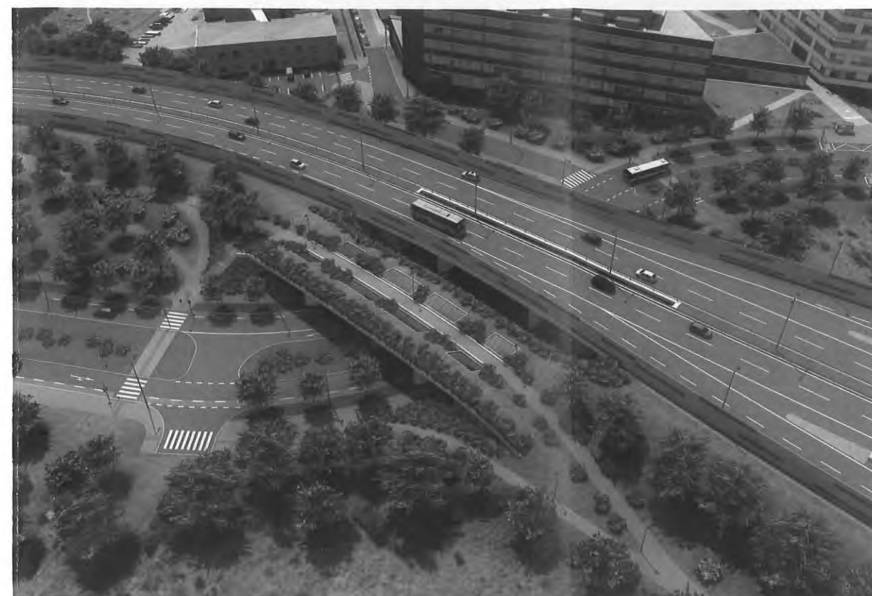
Skica a výsledná vizualizace biokoridoru přecházejícím po mostě přes Novou Radlickou ulici. Prostor pod mostem je otevřen a prosvětlen navrženými prosvětlovacími okny.
