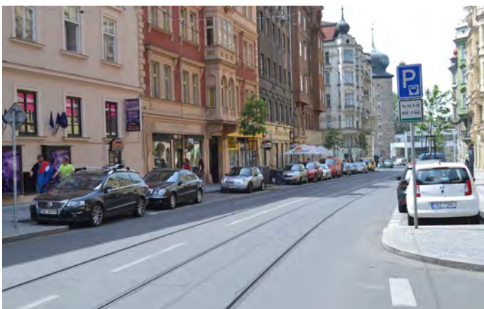
015 Asfaltový kryt ve vozovce poskytuje tichou jízdu automobilů a jasně vymezuje dopravní a pěší prostor. [ Praha, Myslíkova ]
