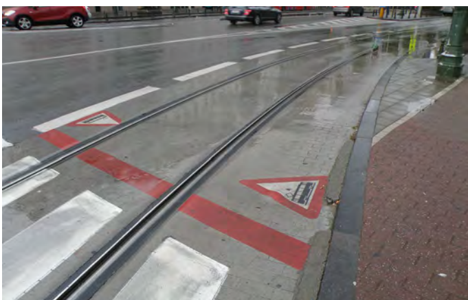
020 Litý beton odlišující tramvajovou trať od okolní vozovky [ Belgie, Brusel ]
