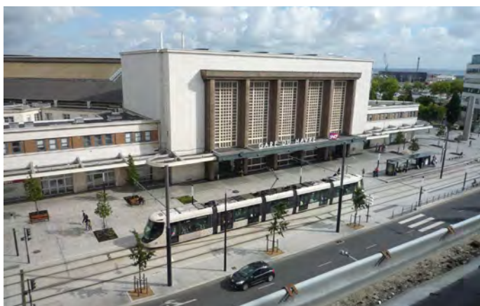
010 Významný předprostor nádraží s tramvajovou zastávkou, který slouží jako sdílený a rozptylový prostor pro pohodlný přestup [ Francie, Le Havre ]
