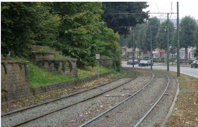
023 Zásyp drceným štěrkem jemné frakce zvyšuje pohledovou kvalitu tratě a zároveň umožňuje pohodlné přecházení v případě potřeby [ Belgie, Brusel ]
