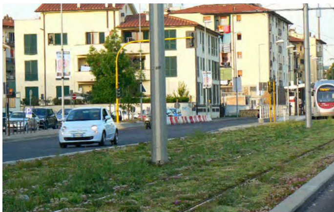
002 Příklad extenzivního povrchu tramvajové tratě s různorodým složením suchomylných bylin bez potřeby údržby [ Itálie, Florencie ]
