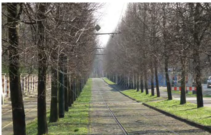
012 Příklad vhodného provedení tramvajové tratě mimo základní uliční profil ve městě [ Praha, Mariánské hradby ]
