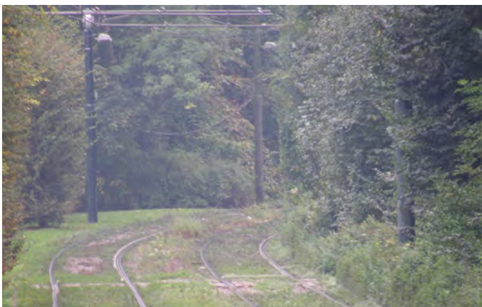
025 Tramvajová trať přebírající charakter okolní vegetace [ Belgie, Brusel ]
