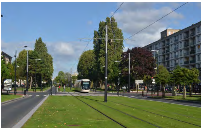
021 Intenzivně udržovaný vegetační povrch tramvajového pásu [ Francie, Le Havre ]
