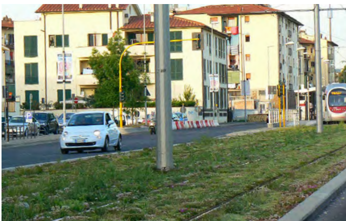
022 Příklad extenzivního povrchu tramvajové tratě [ Itálie, Florencie ]
