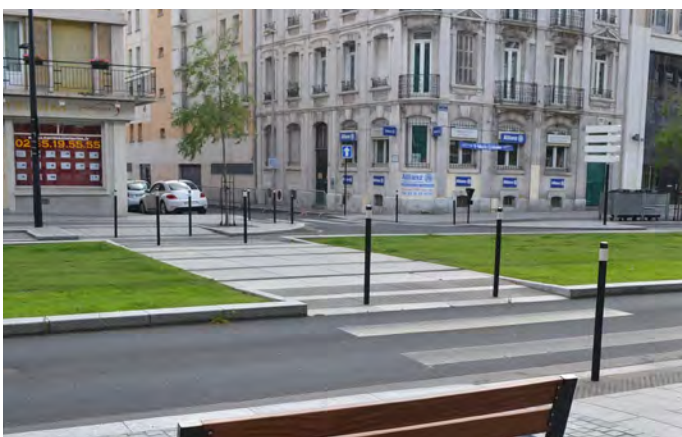
024 Příklad vhodného řešení pěší vazby přes nepojížděnou tramvajovou trať s kvalitně řešeným architektonickým detailem [ Francie, Le Havre ]
