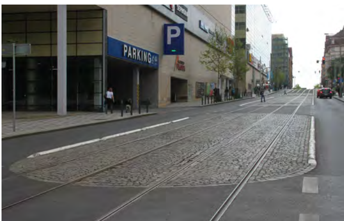
017 Dlážděný kryt tramvajové trati vymežující prostor pro jízdu tramvaje [ Praha, Jičínská ]
