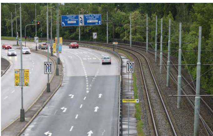
026 Tramvajová trať jako železniční těleso mimo uliční profil [ Praha, Modřanská ]
