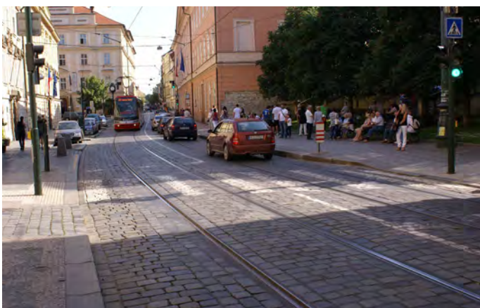
013 Dlážděný kryt z vozovkové dlažby vhodný pro historické prostředí města [ Praha, Karmelitská ]
