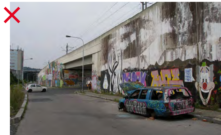
007 Nevhodná forma mimoúrovňového tramvajového tělesa vytvářející fyzickou bariéru a sociálně-patologická místa [ Praha, Modřanská ]
