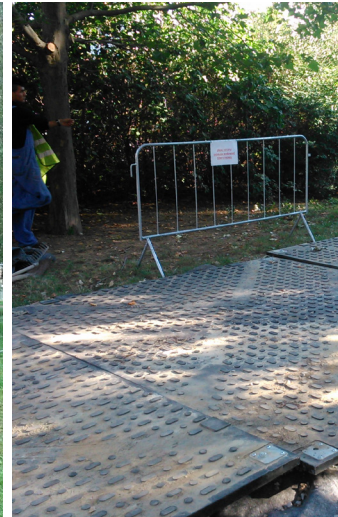
Obr. 45 Ochrana před zhutněním KZ
