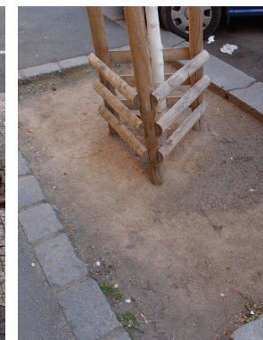
Obr. 13 Jemnozrnný mlát s patrnou plochou s tvorbou řas svědčí o pomalé propustnosti
