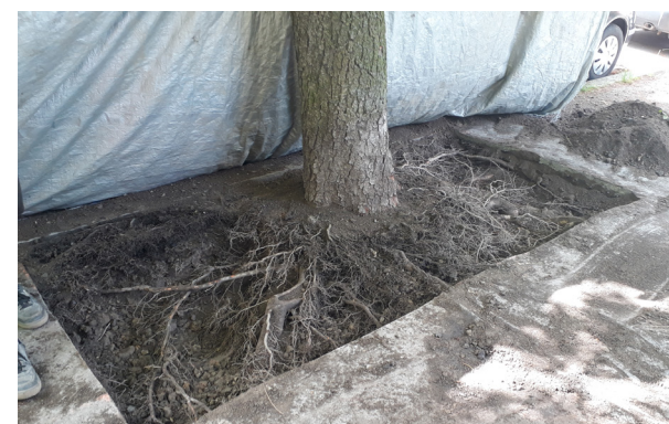
Obr. 47 Využití nedestruktivního způsobu výkopu v oblasti SVKT a KKZ
