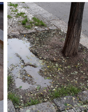
Obr. 14 Zhutněná stromová mísa neumožňuje však srážkové vody
