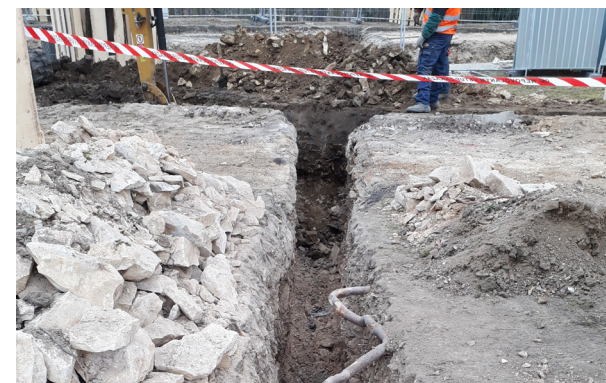
Obr. 48 Ruční výkop se zachováním kořenů ve sdíleném kořenovém prostoru
