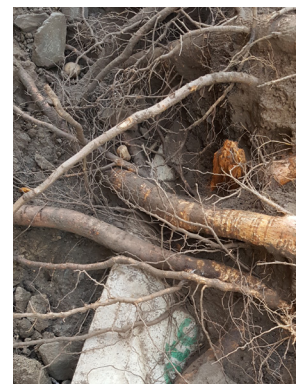
Obr. 10 Kořenová bariéra cca 0,25 m od osy kmene
