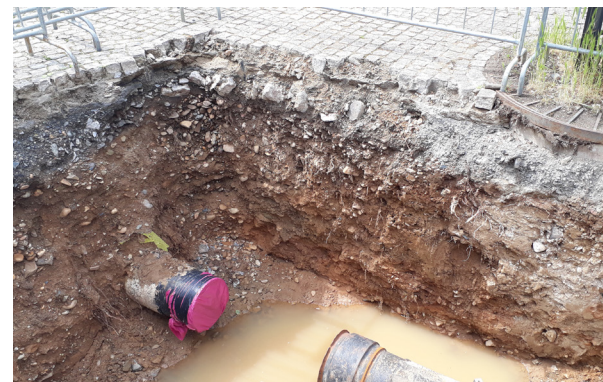
Obr. 9 Prokořenění ve více provzdušněných vrstvách a v zásypu plynovodu
