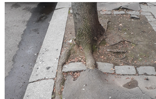
Obr. 6 Úspěšně rostoucí stromy se snaží kompenzovat limity výsadbové jámy prorůstáním pod okolní povrchy
