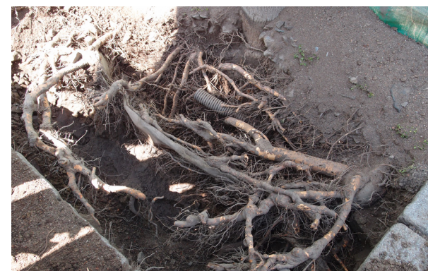
Obr. 46 Využití nedestruktivního způsobu výkopu v oblasti SVKT a KKZ
