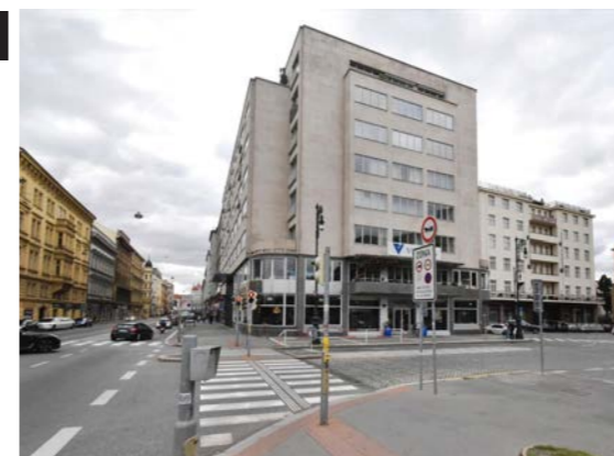
předpolí Štefánikova mostu
