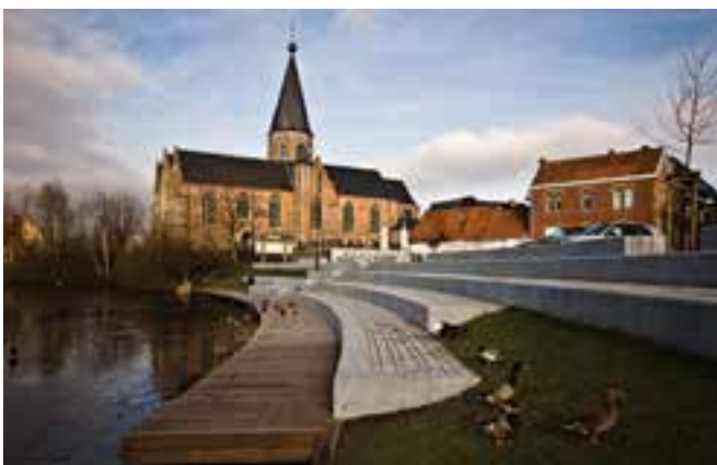
BETONOVÉ POBYTOVÉ SCHODY NA NÁBŘEŽÍ
