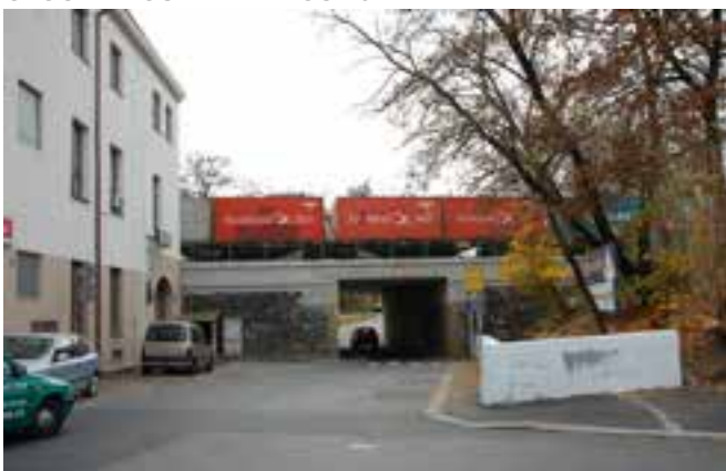
ŽELEZNIČNÍ VIADUKT – DRÁŽĎANSKÁ TRATĚ
