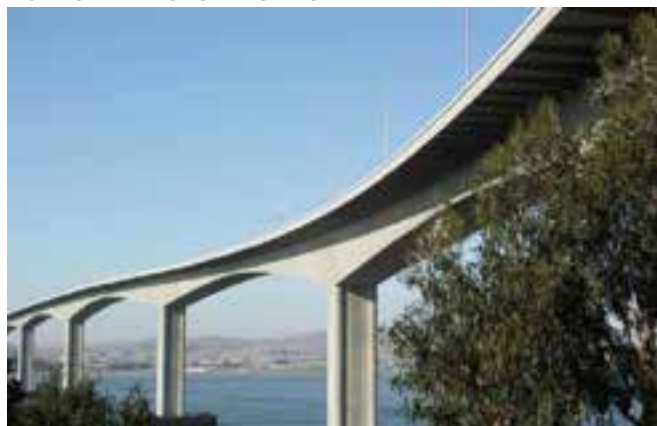
PŘÍKLAD TRAMVAJOVÉHO MOSTU – SPOJITÝ NOSNÍK
