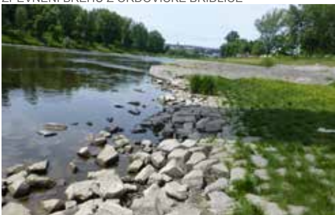
ZPEVNĚNÍ BŘEHU, ZAPOJENÍ VEGETACE
