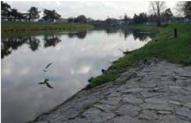
ZPEVNĚNÍ BŘEHU Z ORDOVICKÉ BŘIDLICE
