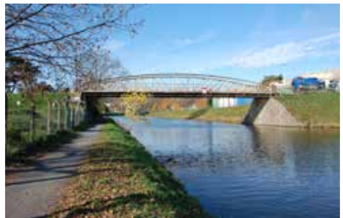
MOST BÝVALÉ POLNÍ DRÁHY Z HISTORICKÉ ČISTÍRNY
