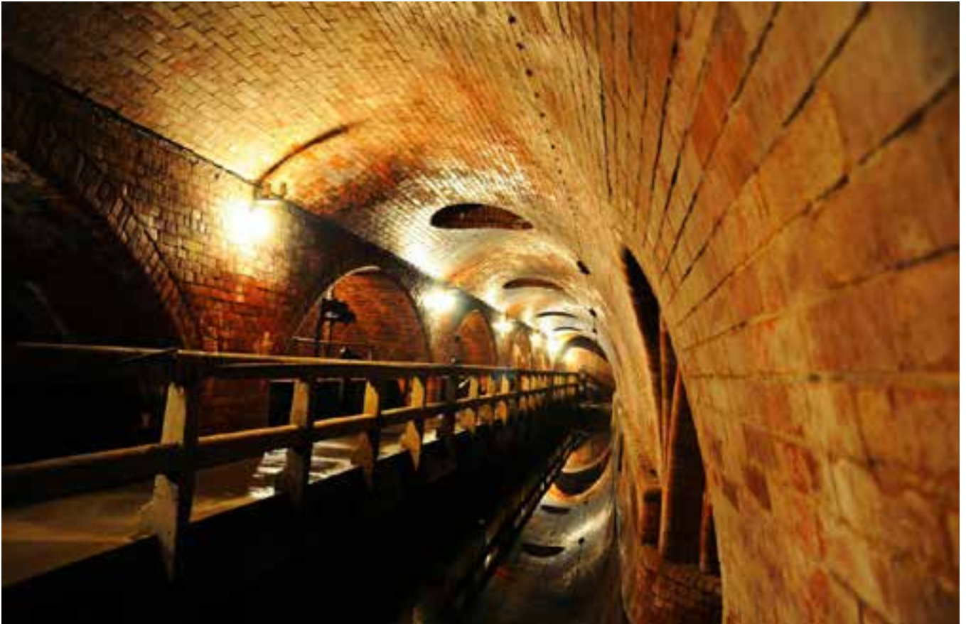
TECHNOLOGICKÉ PODZEMÍ STARÉ KANALIZAČNÍ ČISTÍRNY V BUBENČI
