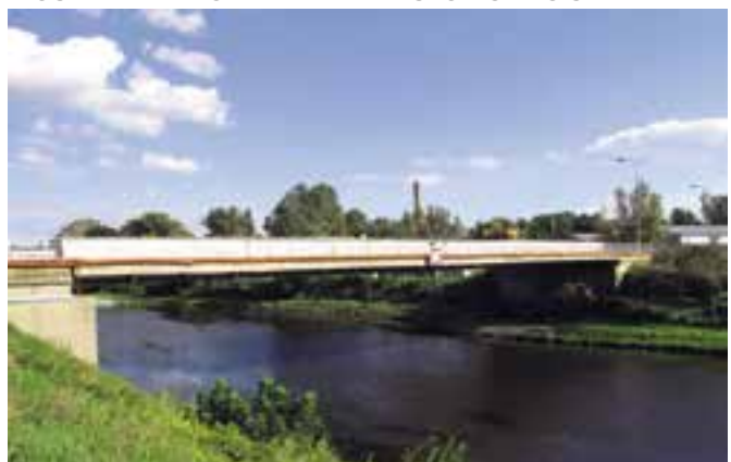
SILNIČNÍ MOST – ÚČOV
