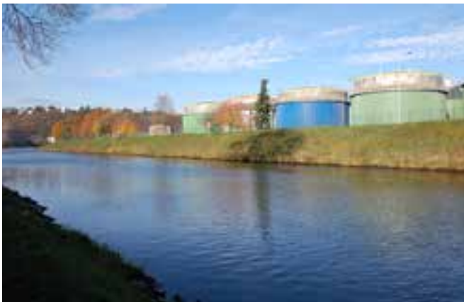
KALOJEMY – ČISTÍRNA ODPADNÍCH VOD
