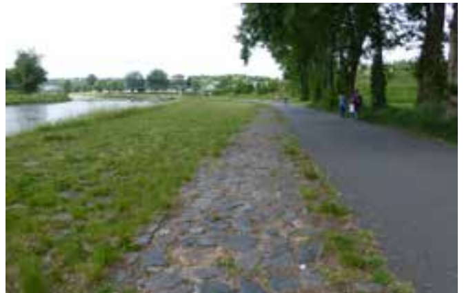
ZPEVNĚNÍ BŘEHU, ASFALTOVÁ CESTA
