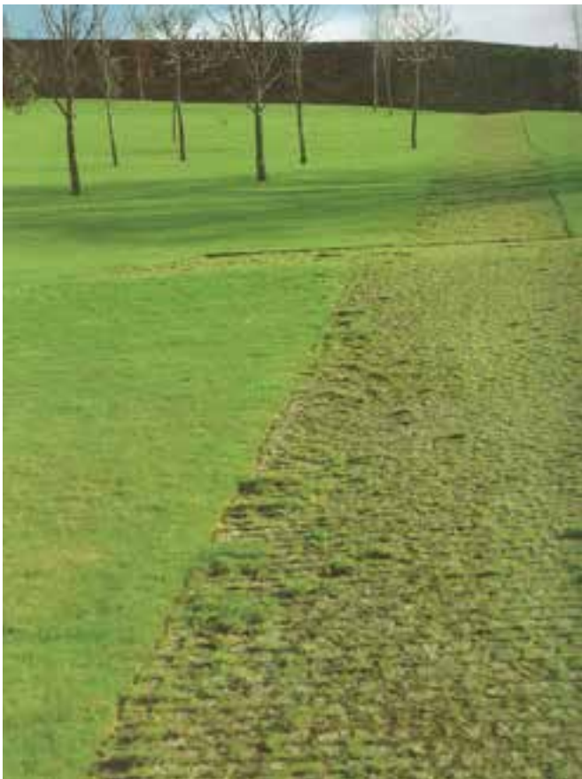
KAMENNÁ ODSEKOVÁ DLAŽBA SE ZELENOU SPÁROU
