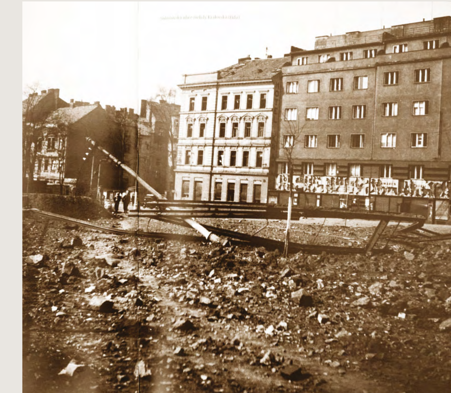
Pohled z dnešního parku na domy v Sokolovské ulici č. 247 a 251 po bombardování v roce 1945
